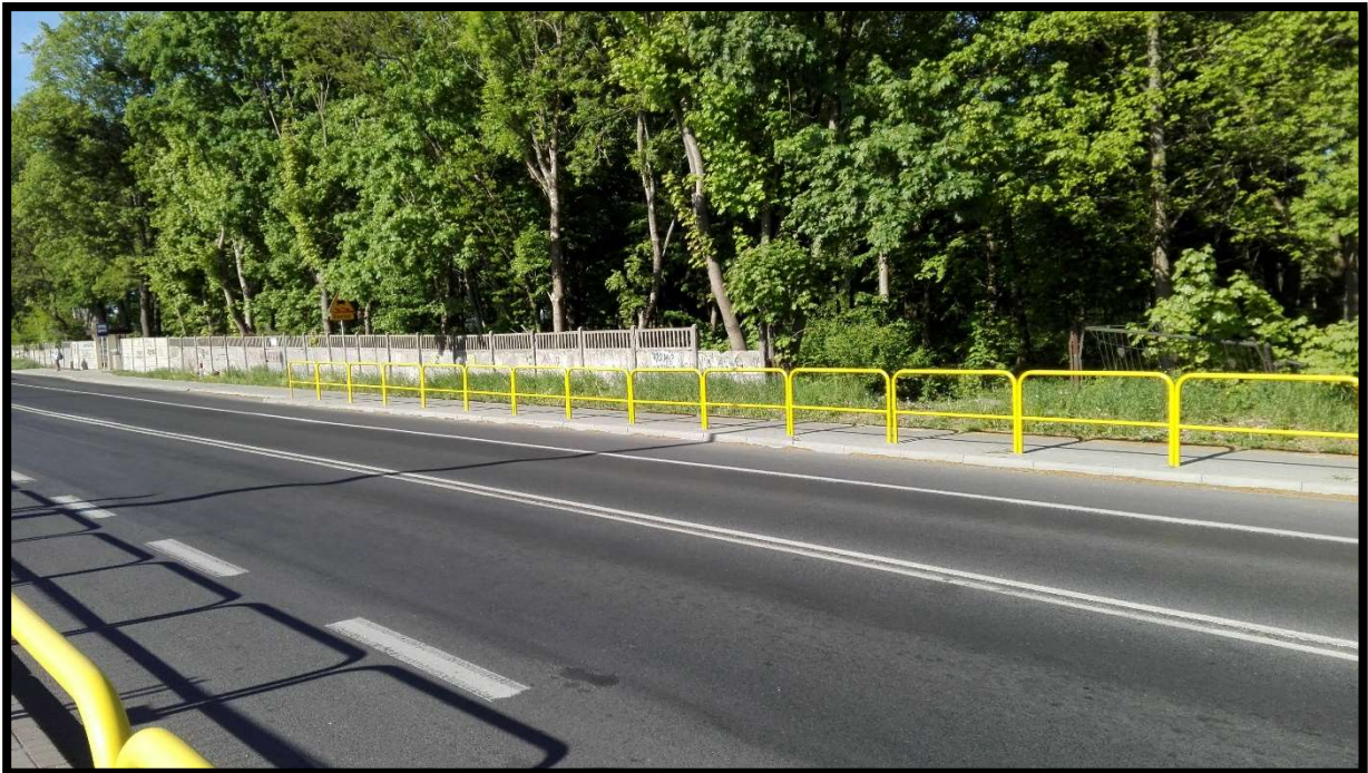
Zdjęcie nr. 3 Zdjęcie przedstawia szpecące betonowe ogrodzenie na prawo od niedawno odświeżonego przystanku autobusowego.
